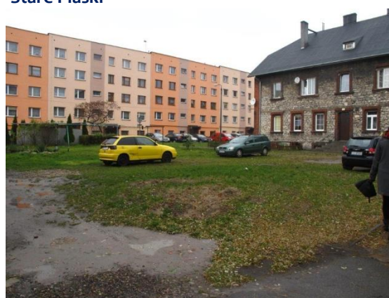
Rysunek 23. Zabudowa mieszkaniowa osiedla Stare Piaski
